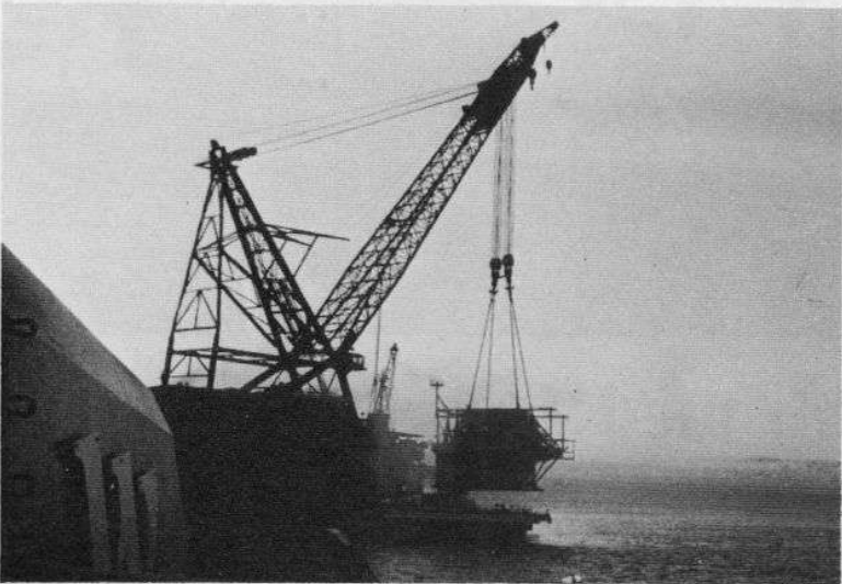
"37/4A" lyfts från Contilift I av Micoperi 26 i april 1975.
